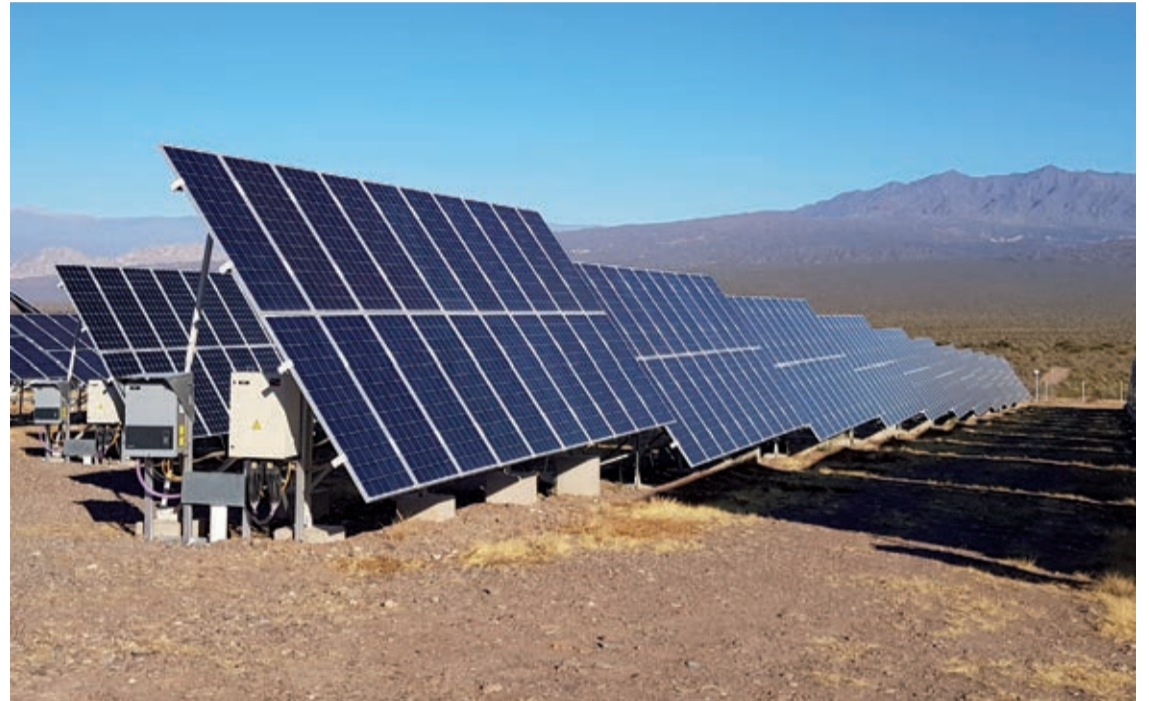
Genneia ratificó su compromiso productivo con Mendoza y construirá dos complejos fotovoltaicos por una inversión de u$s 250 millones
